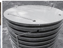
民有林及び国有林野内にシカ捕獲個体処理のための大型排水管を設置
