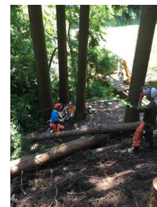
作業道の敷設
