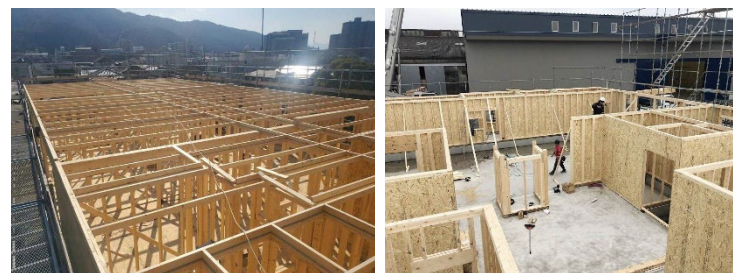
大型木造非住宅建築の施工事例
