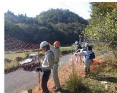
リーダー研修の様子 (防護柵の設置実習)
