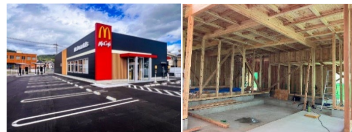
安芸熊野店(広島県熊野町、令和6年オープン)
