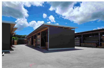
横架材のストックヤード
