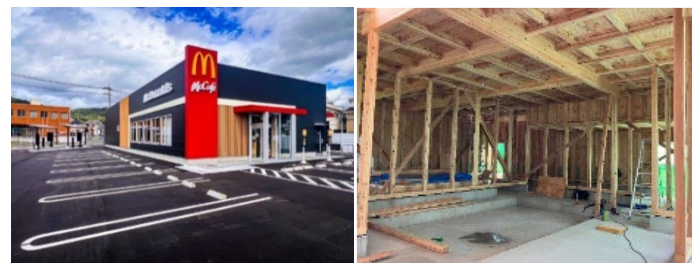
安芸熊野店(広島県熊野町、令和6年オープン)
