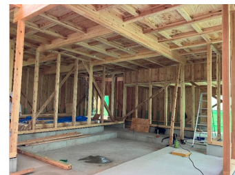
柱等にJAS構造材を使用 (広島県熊野町 令和6年竣工)
