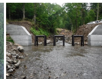
流木捕捉式治山ダム工
