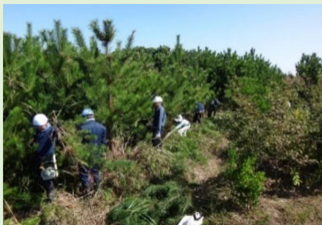
枝打・つる切作業中の様子
