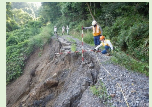
現地調査の様子
