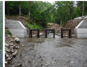
流木捕捉式治山ダム工
