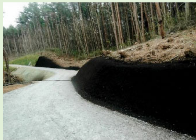
林道の新設工事完了後の様子
