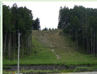
完成後の様子
