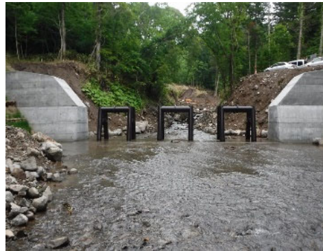
流木捕捉式治山ダム工
