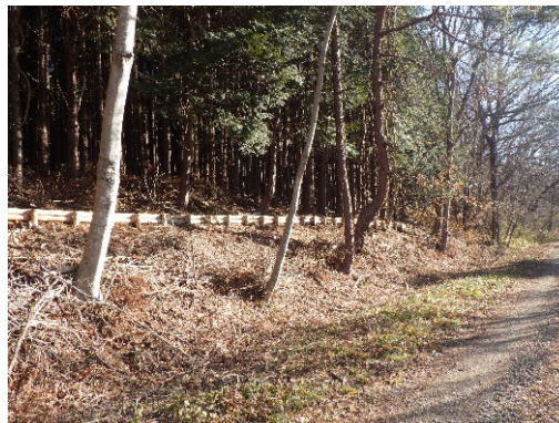
里山再生事業による除伐及び丸太筋工
