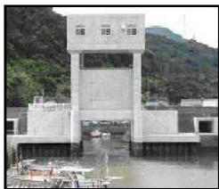
津波・高潮対策としての水門整備
