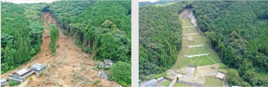
・熊本県 あしきたぐんあしきたまち 葦北町 ・（左）山腹崩壊（令和2（2020）年7月） （右）工事完成後（令和5（2023）年4月）
