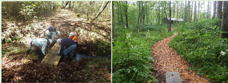
手作りの木橋を設置する様子 ウッドチップ敷設後の様子
