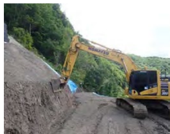
治山事業におけるICT活用事例 （MG（マシンガイダンス）付きバックホーによる掘削）
