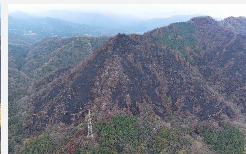
ドローン調査で確認された被災箇所 (愛媛県西条市 永納山国有林)
