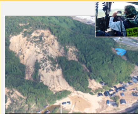
豪雨による土砂流出 (石川県珠州市 民有林)
