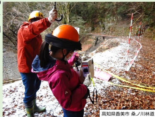
地上レーザ測量の様子
