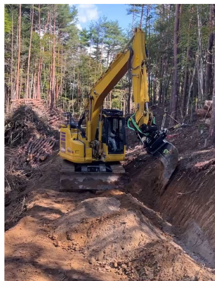
林道工事などの狭小な現場でも掘削・法面整形が可能
