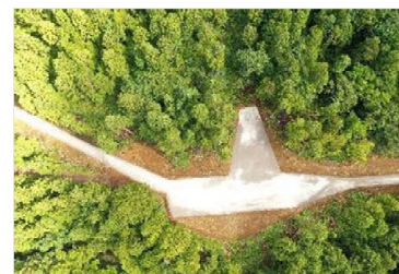
改良工事で設置された車回し
