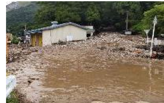
降雨により保全対象へ土砂が流出
