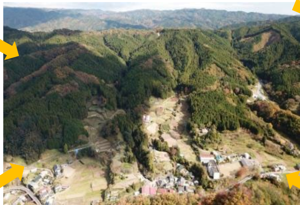
面的な予防保全対策の実施
