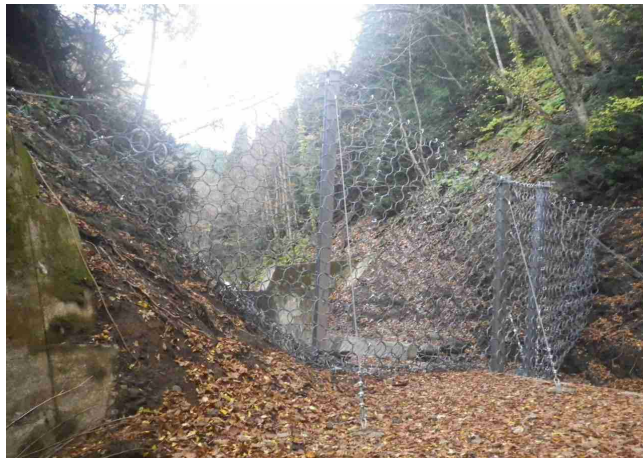
ワイヤーネット工
