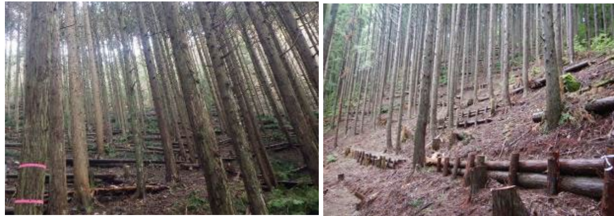
筋工と保安林整備の実施状況
