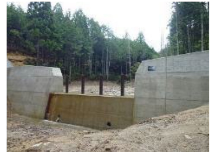
流木捕捉式治山ダムの整備
