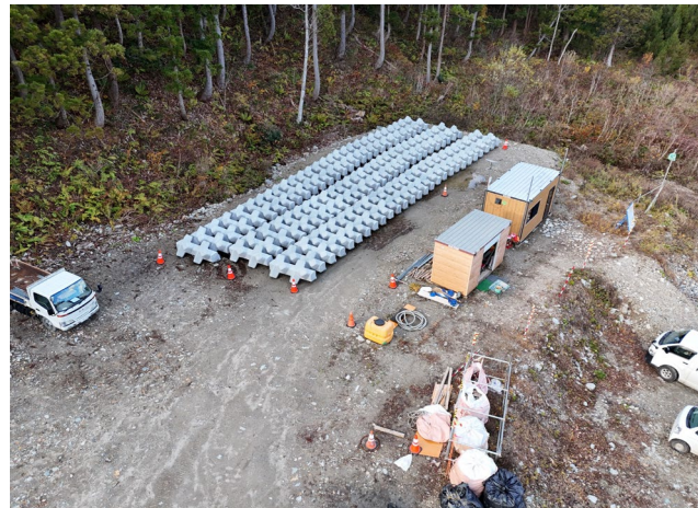
資材のストック箇所の調整・確保
