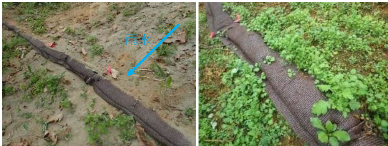
軽量資材を活用した筋工の導入（北海道胆振東部地震）
