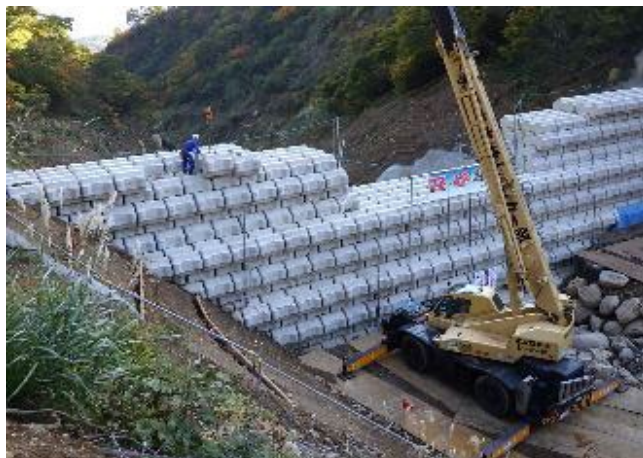
ブロック積堰堤
