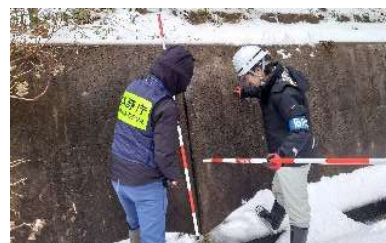
激甚災害後の治山施設の点検支援
