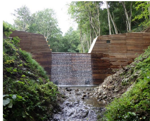
丸太残存型枠 (福島県福島市) [国有林治山事業]
