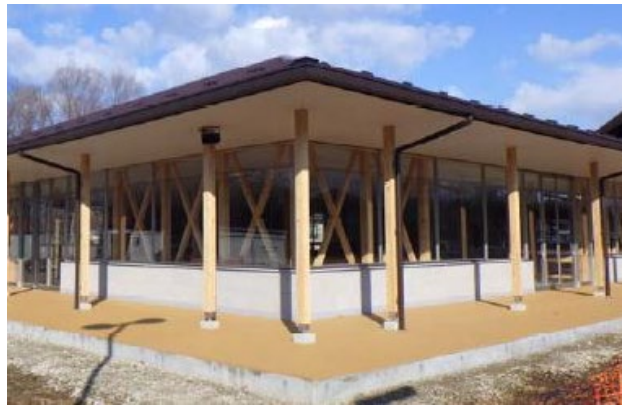
道の駅那須高原友愛の森 新館 農産物直売所 (栃木県那須郡那須町)〔農山漁村振興交付金〕 ※栃木県産材等を活用
