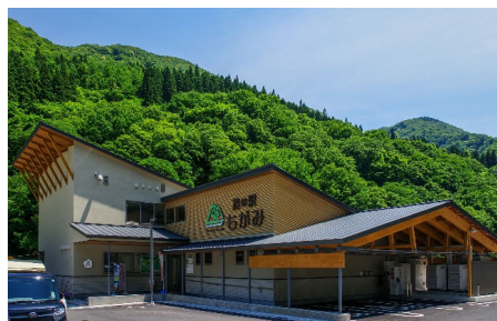
国土交通省 道の駅ながみ 情報提供施設 (山形県)
