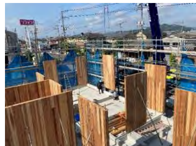
木造事務所建設の様子
