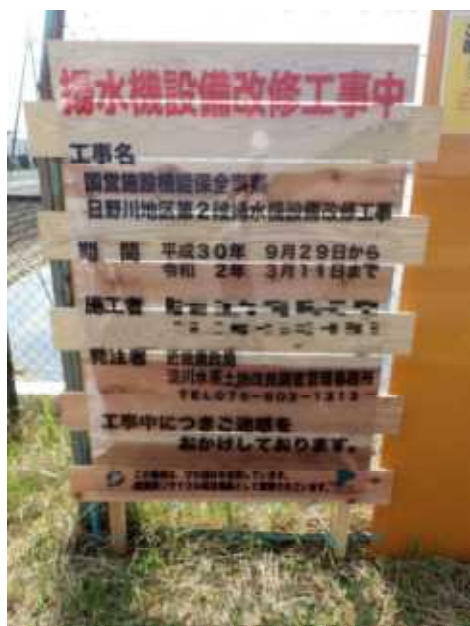
工事用看板 (滋賀県蒲生郡竜王町) [国営かんがい排水事業]
