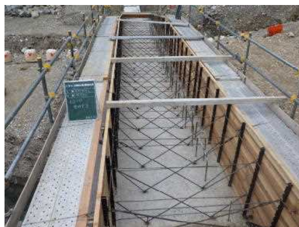
平割材残存型柵（岐阜県白川村） [国有林治山事業]
