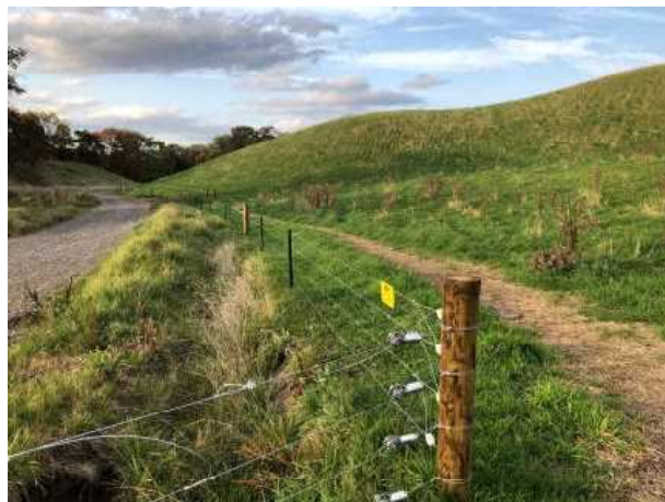
隔障物工（電気柵）（北海道小清水町） [草地整備型 公共牧場整備事業]
