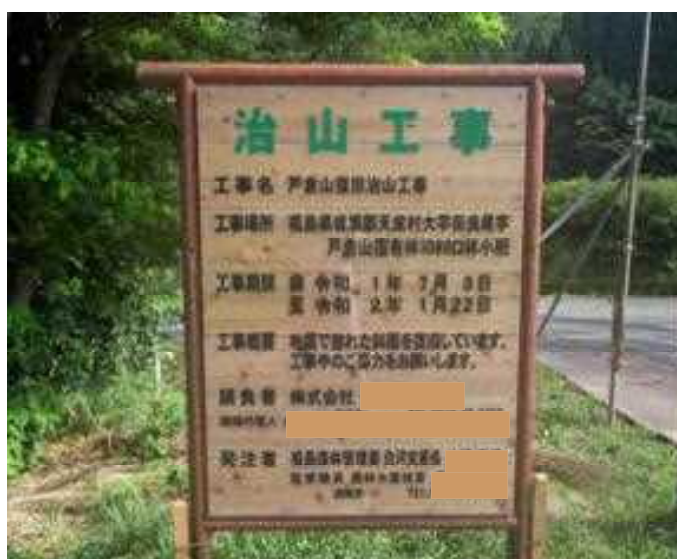
工事用看板 (福島県天栄村) [国有林治山事業]
