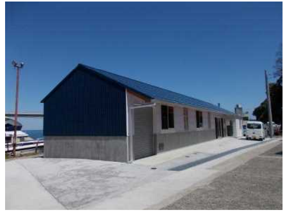
作業保管施設（神奈川県真鶴町）
