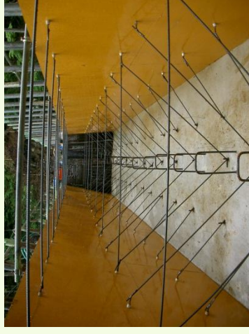
型枠を組んだコンクリート打設前のようす
