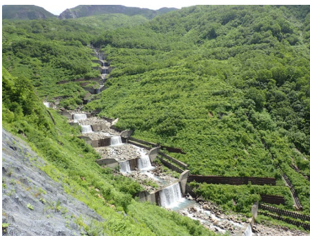
施工後約 30 年が経過し植生に覆われた治山事業実施箇所
