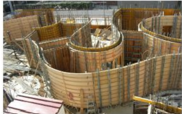
รูป 2-8 ไม้อัดแบบหล่อคอนกรีต
