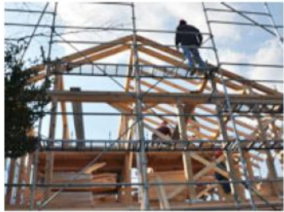
รูป 2-26 สถานที่ก่อสร้างที่ประกอบขึ้นชิ้นส่วนงานตัดเตรียมสำเร็จ (Pre-cut)
