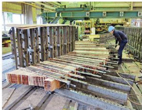
รูป 4-10 การกดอัดชิ้นงานที่มีความโค้งหน้าตัดใหญ่ด้วยแรงงานคน
