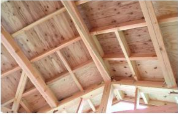
Gambar 2-9 Contoh penggunaan kayu lapis untuk konstruksi
