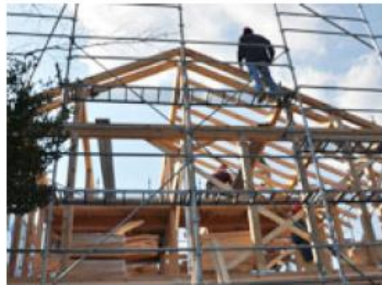
Gambar 2-26 Lokasi konstruksi tempat kayu pra-potong dirakit
