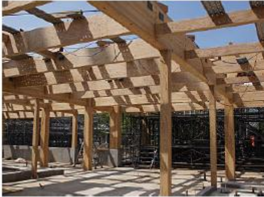
Gambar 2-11 Contoh penggunaan LVL untuk konstruksi (balok penopang atap) (Sekolah PAUD Marumori)
