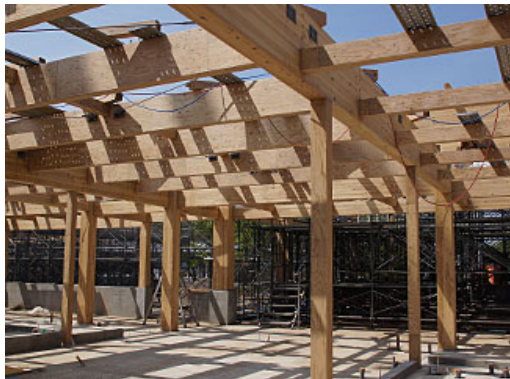
図 2-11 構造用 LVL の使用例(梁) (丸森保育園)
