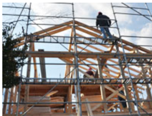
図 2-26 プレカット材を組み上げる建築現場
