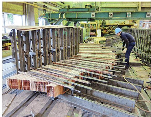
図 4-10 手作業による大断面湾曲材の圧締作業
