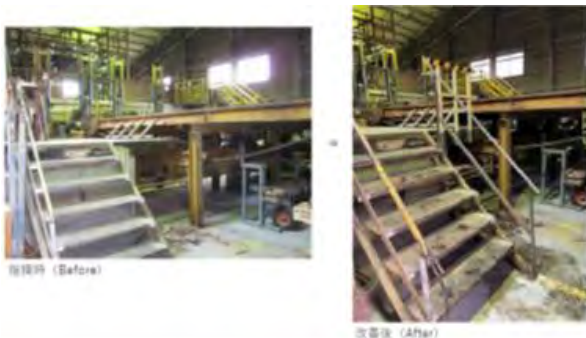
手摺や柵の設置
