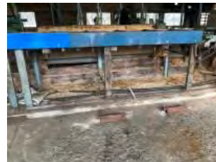
巻き込まれ防止のカバーの設置
