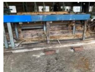
巻き込まれ防止のカバーの設置
