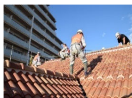
被災住宅の応急修理の 訓練のイメージ
