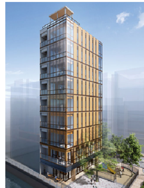
地上9階建て混構造事務所
