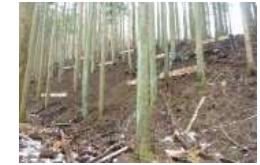
移動抑制対策(筋工)
