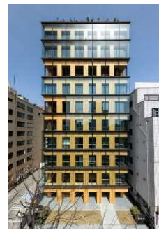
純木造 11階建て研修所
