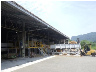
木材投入状況
