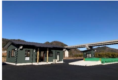
管理棟・トラックスケール
