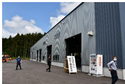
製材工場外観
