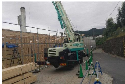
地域材を使用した福祉施設の建設現場
