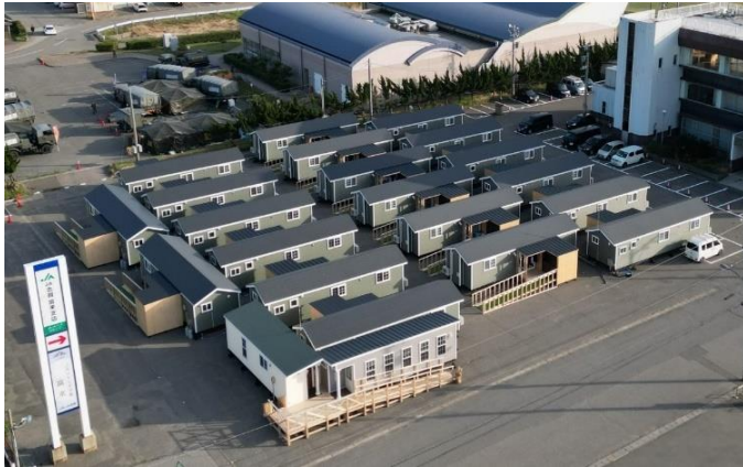
令和6年能登半島地震(石川県志賀町)
