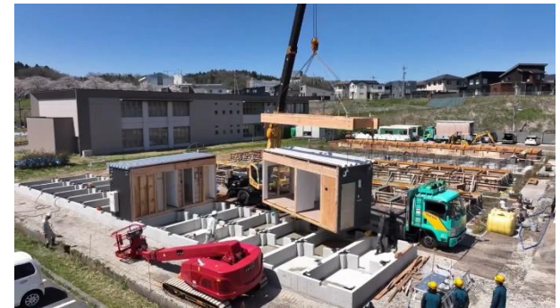
クレーンで設置
