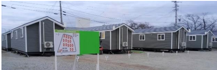
令和元年東日本台風(長野県長野市)
