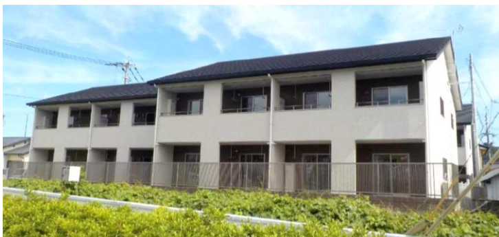
(大津町)木造共同住宅12戸(2階建て)
