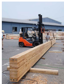
鉄筋入り集成材による 18mの大梁(H27)
