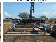
CLT地盤補強(R3)
