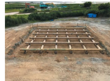
木製浮き基礎の実大実験(R3)
