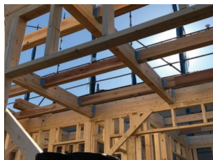
スギ材による床根太工法の開発(R2)
