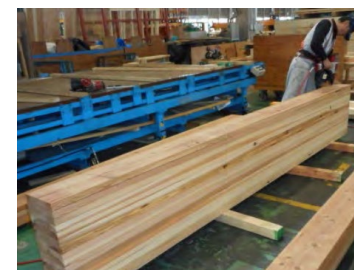
工場での釘打ち(H30)
