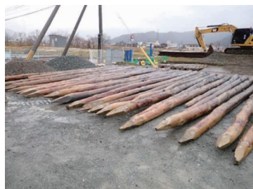
86年前に設置された杭丸太の掘り出し試験(R6)
