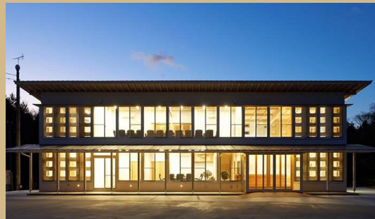
荒川材木店事務所（福島県いわき市） 無垢大断面製材を使用【いわき材加工センター】
