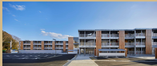
いわきCLT復興公営住宅（福島県いわき市） WOOD.ALCを使用【協和木材】
