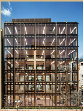
ジューテック本社ビル（東京都港区） 燃え止まり型耐火集成材を使用 【藤寿産業】
