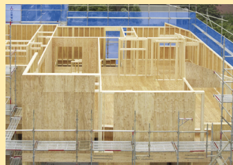
桢組壁工法（2×4 工法）
