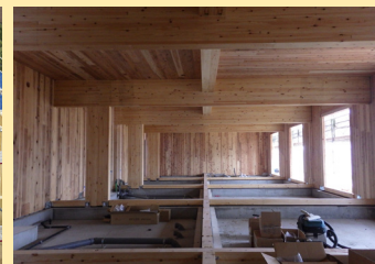
CLT パネル工法
