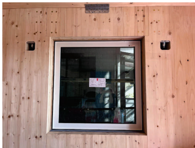
窓の施工写真
