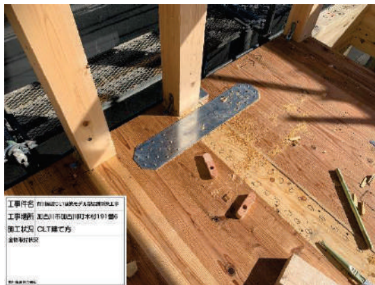
母屋組開始、既存 CLT にスリムヘビーにて固定
