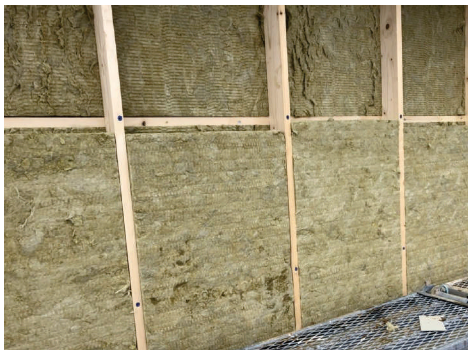
2～3 階壁施工写真
