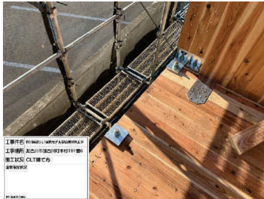
母屋組開始、既存 CLT にスリムヘビーにて固定
