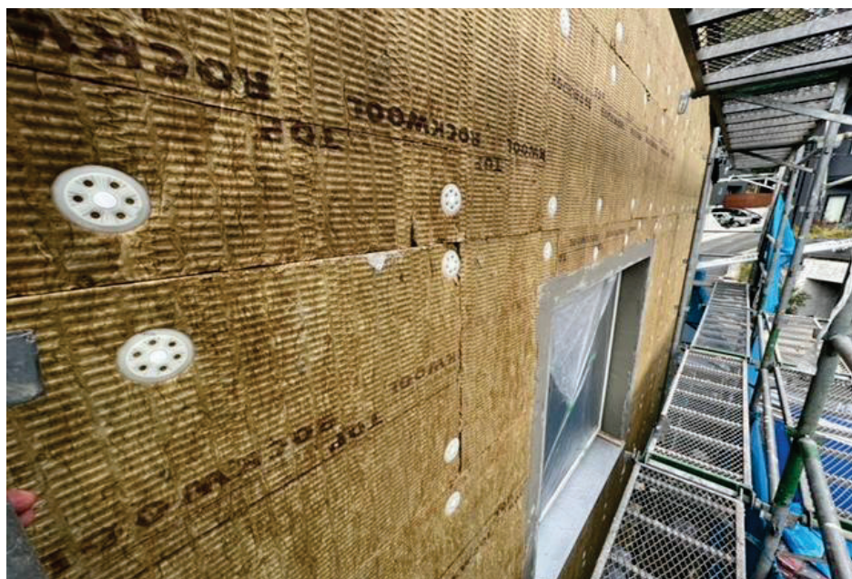
1 階壁施工写真
