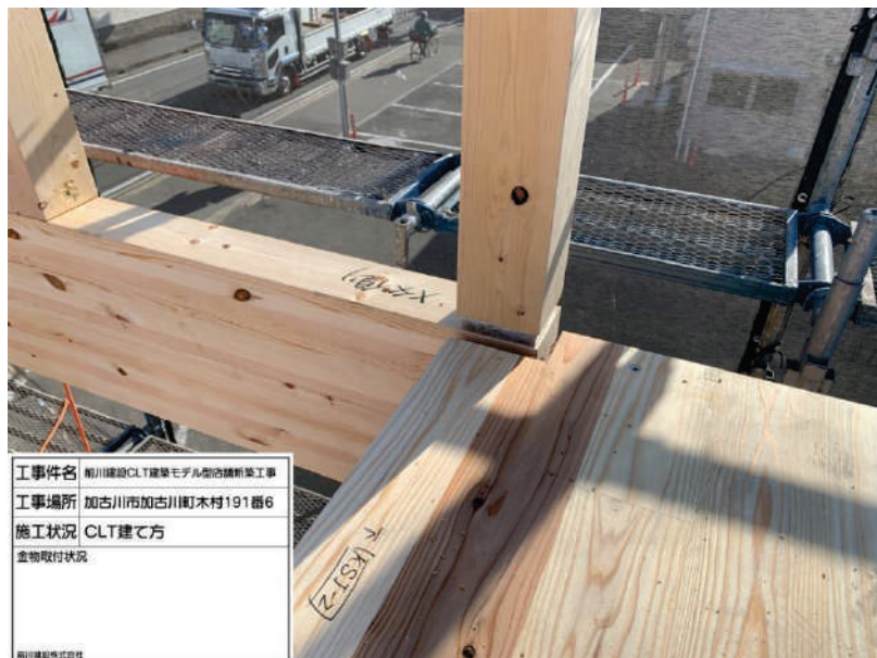
CLT 組付け連結金物を固定
