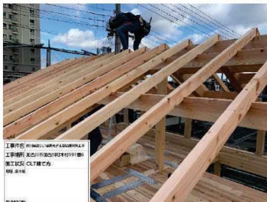
屋根垂木掛け、タルキックにて固定
