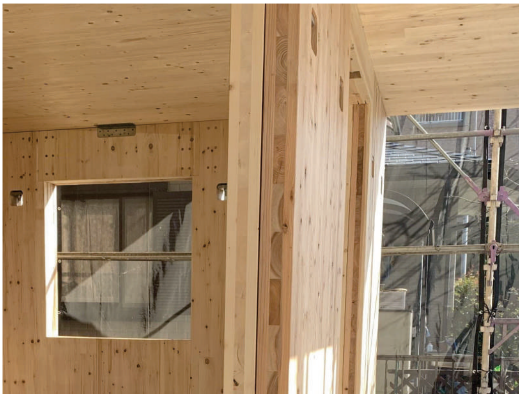
1階壁断面写真 左：トドマツ 右：スギ
