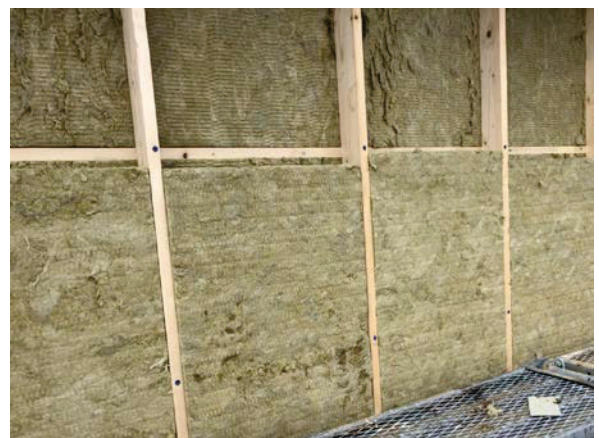
2 階断熱材施工写真
