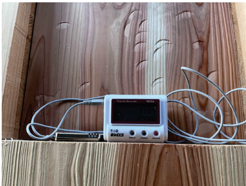
データロガー設置写真（断熱施工前）
