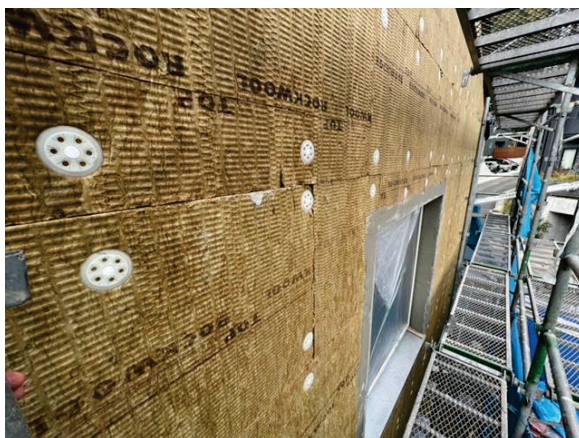
1 階断熱材施工写真
