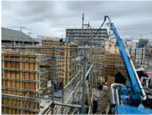
RC 壁 打設時
