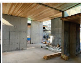
CLT 屋根設置時写真
