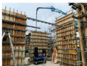
RC 壁打設時写真
