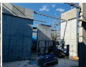
RC 壁型枠脱型時写真
