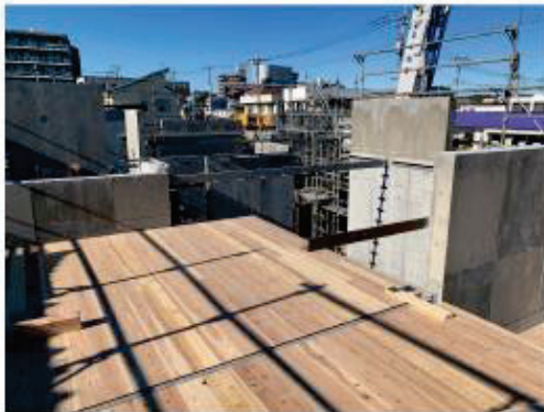
CLT 屋根 設置時
