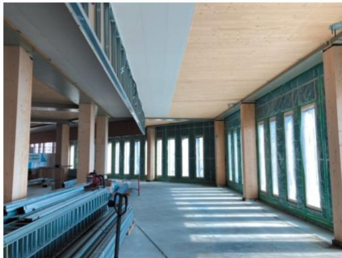
ヘルシンキ市南西部エリアの木造街区プロジェクト「ウッドシティー」の4棟目となる建物では木造+RC造+鉄骨造のハイブリッド構造が採用された。梁に用いた木と鉄骨のハイブリッドシステムは最大9mスパンの大空間が可能。工期短縮と環境負荷の低減につなげている（写真：坂口大史）
