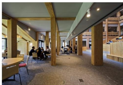
3層吹き抜け空間の手前には製材品の束ね柱を用いた。断面サイズは300×360mm。長手方向と短手方向の向きにあえて変化を持たせている（写真：イクマサトシ） [画像のクリックで拡大表示]
