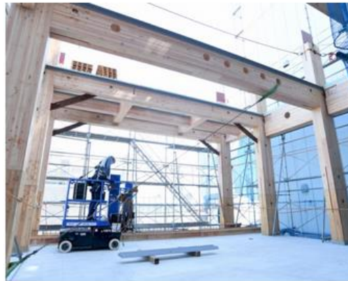
11階木質ラーメンの構造体。柱・梁（はり）にはシェルターが開発・供給する木質耐火部材「COOL WOOD（クールウッド）」の1時間耐火構造仕様を用いた（写真：高木ビル） [画像のクリックで拡大表示]
