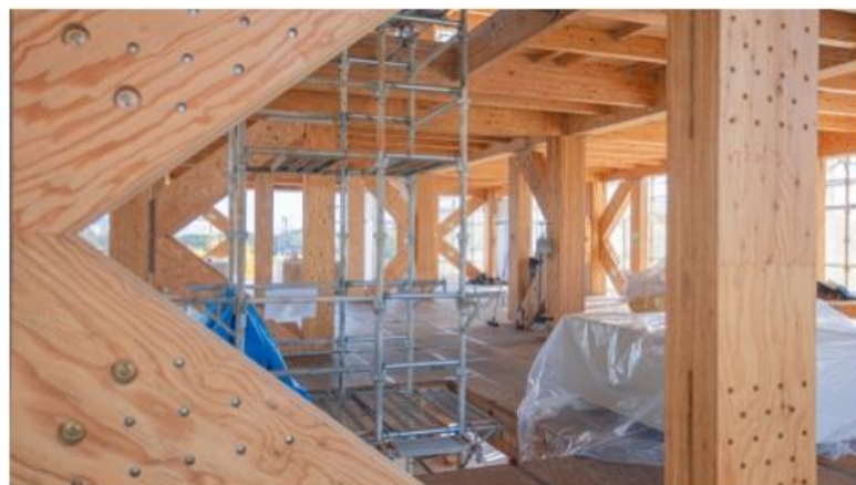
「都島プロジェクト」。8階建て、28mの高さの木造共同住宅だ。木造の主要な構造部材（柱・梁、ブレース）に使用するLVLには国産カラマツ材を、耐震壁や床の一部に使用するCLTには国産杉材を使用している（写真：山代 悟） [画像のクリックで拡大表示]
