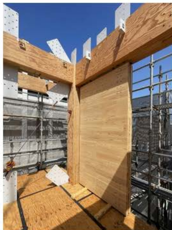
CLTを用いた耐震壁。これもK型ブレースと同様、住戸内部で目に触れやすい箇所は現して仕上げるが、水まわりや共用廊下など目に触れにくい箇所は耐火被覆を施す（写真：ビルディングランドスケープ） [画像のクリックで拡大表示]
