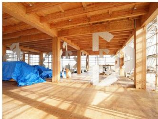
木造フロアの骨組み。建て方はワンフロア当たり1週間ほどで済んだ。施工期間中は雨の吹き込みが厄介となる。とりわけ耐火被覆に用いる石膏ボードは水を嫌うため、今後施工手順を改めて確認する必要があると山代氏は指摘する（写真：ビルディングランドスケープ） [画像のクリックで拡大表示]
