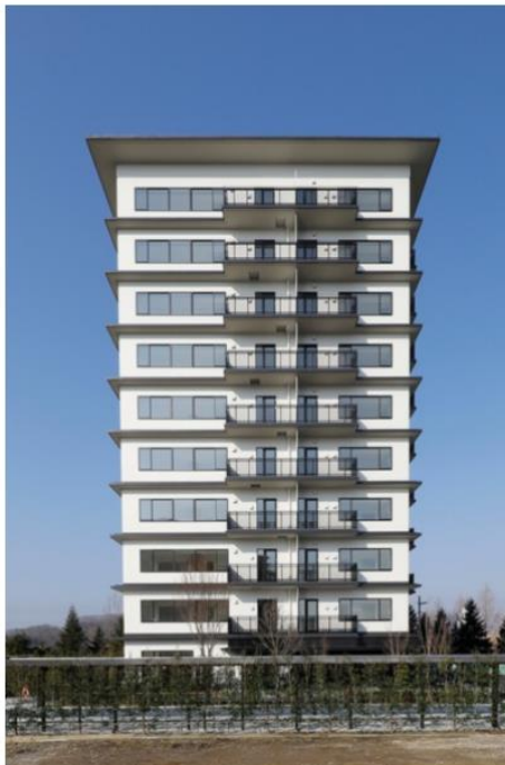
賃貸マンション「PARK WOOD 高森」。CLTを床材に用いた建築物として、防耐火技術、構造技術、施工方法の検証を行い、CLT工事の合理化手法の確立を目指した（写真：三菱地所） [画像のクリックで拡大表示]
