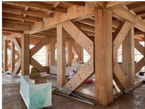
LVLを用いたK型ブレース。住戸内部で目に触れやすい箇所は隠して仕上げるが、水まわりや共用廊下など目に触れにくい箇所は耐火被覆を施す（写真：ビルディングランドスケープ） [画像のクリックで拡大表示]
