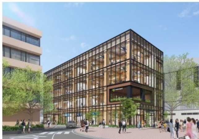
JR国立駅南口の駅前広場側から見た「nonowa国立SOUTH」の外観イメージ。ガラス越しにラーメン架構が見える。柱のスパンは6.5m（出所：JR中央線コミュニティデザイン） [画像のクリックで拡大表示]
