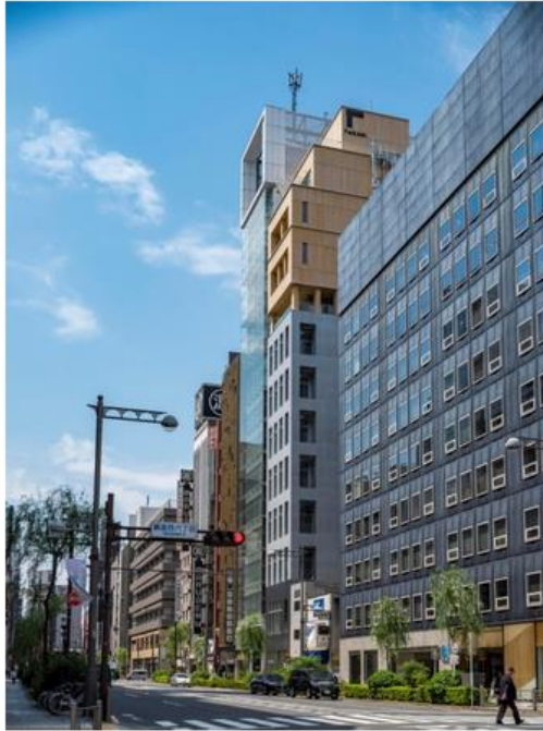
教習場交差点方面からの街並み。地上31mのスカイラインを構く高いビルの上に木箱が載ったかのよう。高木ビル社長の高木秀邦氏は、同じような形で街並みが更新されていくのを期待している（写真：高木ビル） [画像のクリックで拡大表示]
