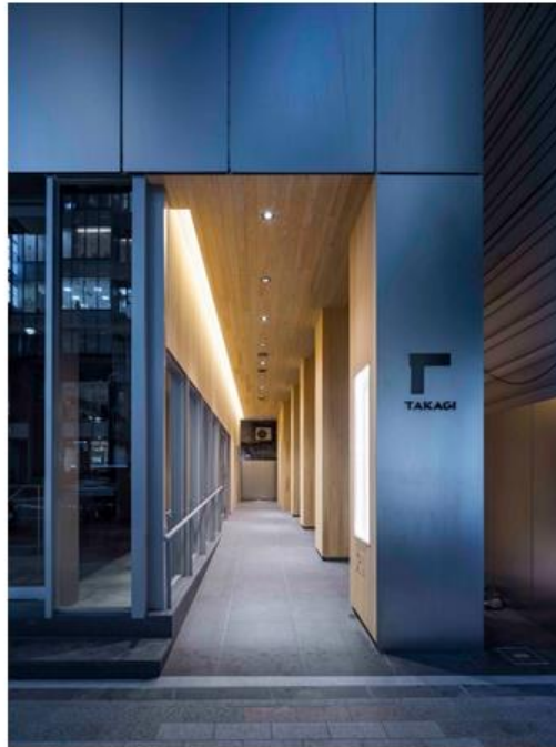
1階エントランス。柱まわりや軒天などは内装材にも用い、多摩産のスギで仕上げる。最上階からの4階に木造フロアを持つビルであることをほのめかす仕掛けだ（写真：高木ビル） [画像のクリックで拡大表示]
