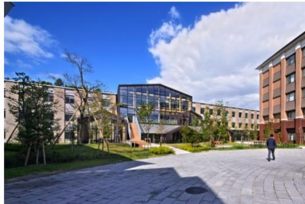
グリーンcommonsは、ガラス張りの部分に木造を、その両脇に鉄骨造を採用する。既存建物の間を抜ける北西からの強風を防ぐ位置に建設された（写真：イクマサトシ） [画像のクリックで拡大表示]
