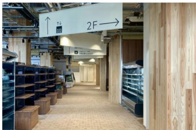
1階、施工中の内観。柱や壁の仕上げには地元多摩産のスギを用いる。スプリンクラーと自然排煙窓を備え、内装制限は適用されていない（写真：大林組） [画像のクリックで拡大表示]
