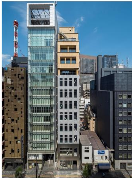
一番上に見えるのは最上階。そこに設置する設備機器を多層座のスギで覆い隠す。スギの表面にはガラスコーティングを施した。最上と最上階の12階との間は外階段でつながる（写真：高木ビル）
