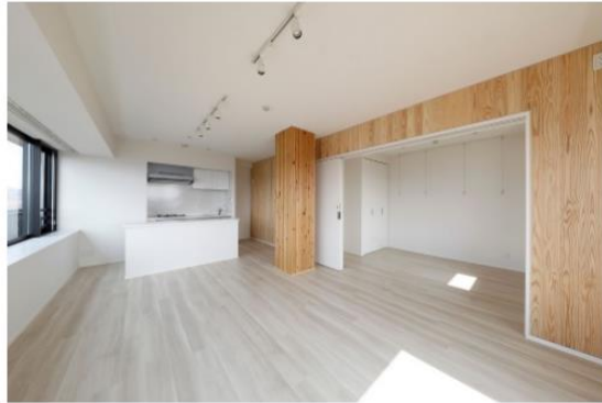
「PARK WOOD 高森」プレミアム住戸のリビング。正面に見える木部現し仕上げの柱は、竹中工務店が開発した「燃エンウッド」（写真：三菱地所） [画像のクリックで拡大表示]
