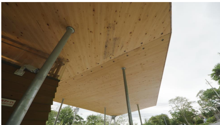
建物外観（天井部分）
