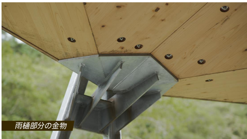
雨樋部分の金物
