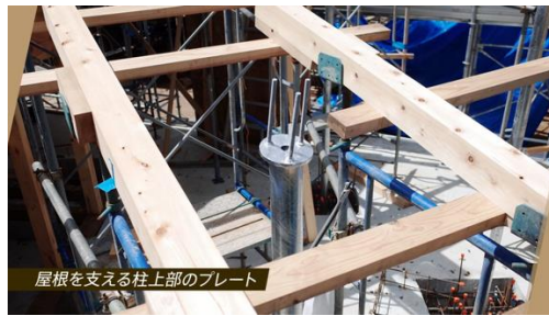
CLTの屋根と柱のシンプルな接合
