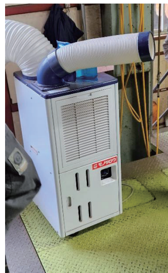
冷風機の設置
