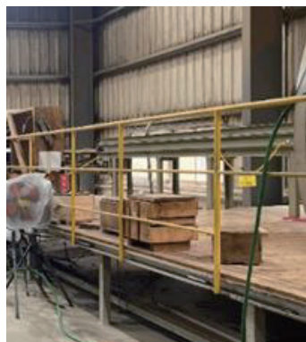
転落防止のための自作による柵の設置
