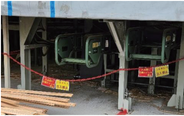
警告標記と物理的な侵入防止用の鎖の設置
