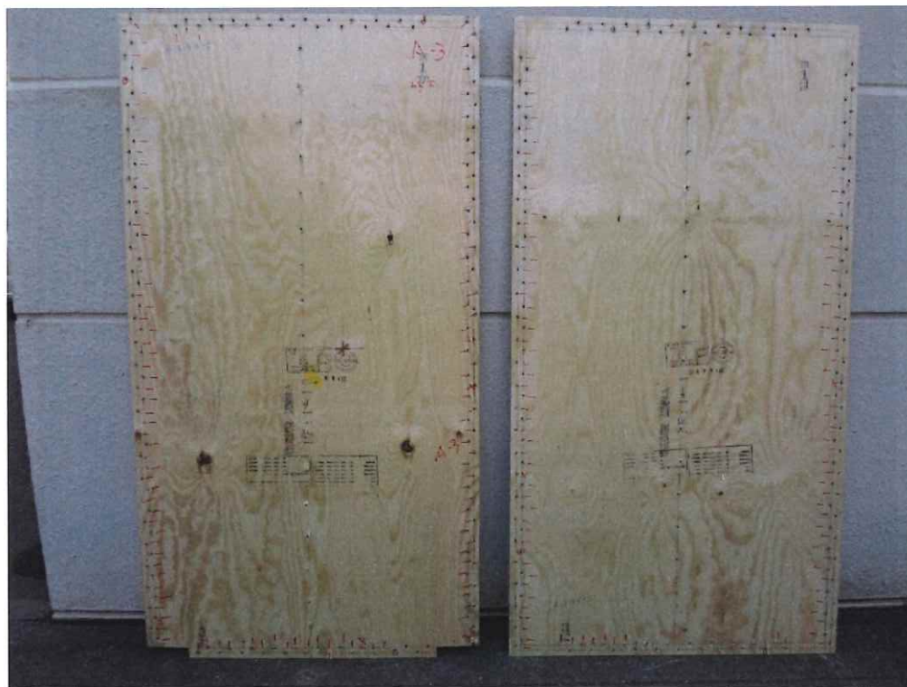
写真 1.18 A-3 解体後 面材(裏)
