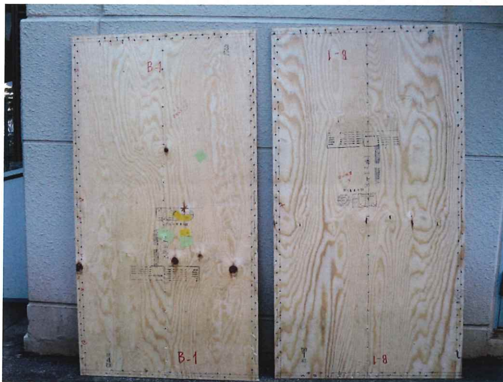
写真 1.26 B-1 解体後 面材(表)
