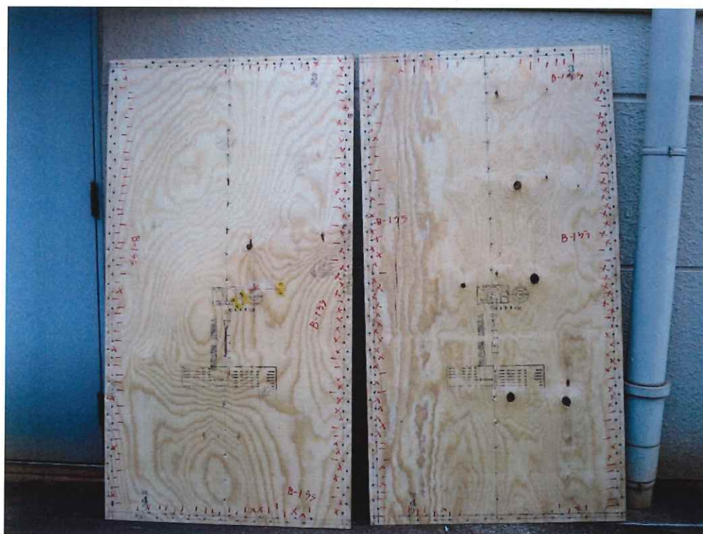
写真 1.27 B-1 解体後 面材(裏)
