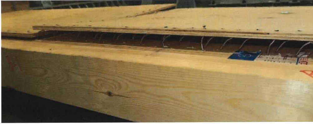
写真 1. 28 B-1 試験終了後 面材の浮き
