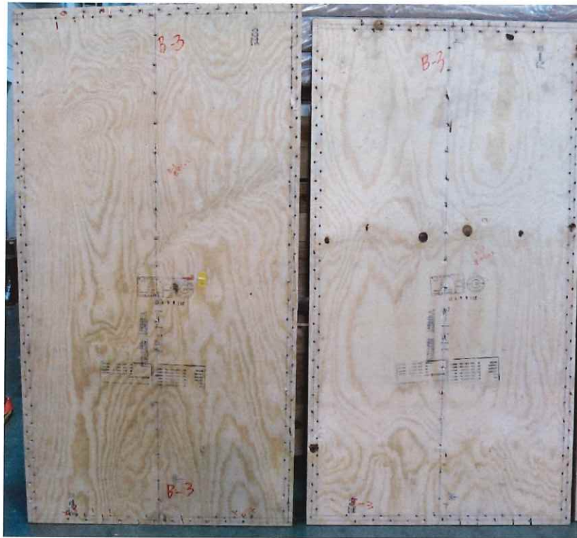
写真 1. 40 B-3 解体後 面材(表)
