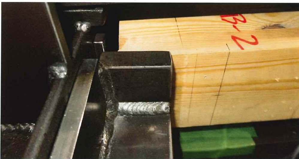
写真 1. 37 B-2 試験終了時 柱脚部の浮き上がり
