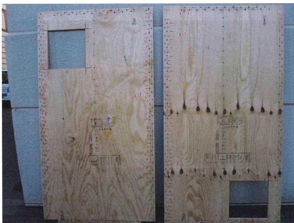
写真 1.4 A-1 解体後 面材(裏)
