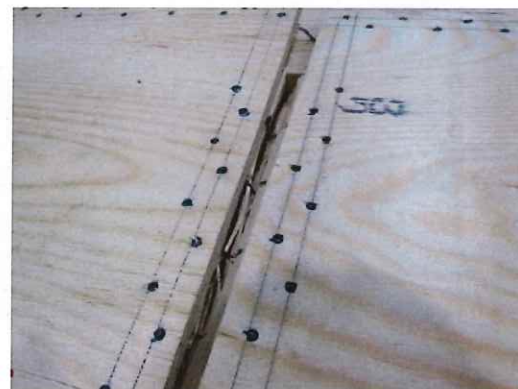
写真 1. 23 A-3 試験終了後 中棧の割れ
