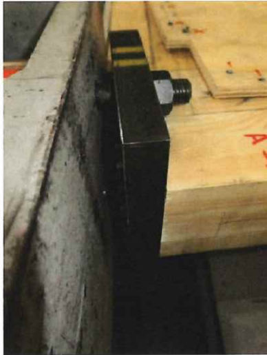
写真 1.11 A-2 試験終了後 柱脚の浮き上がり
