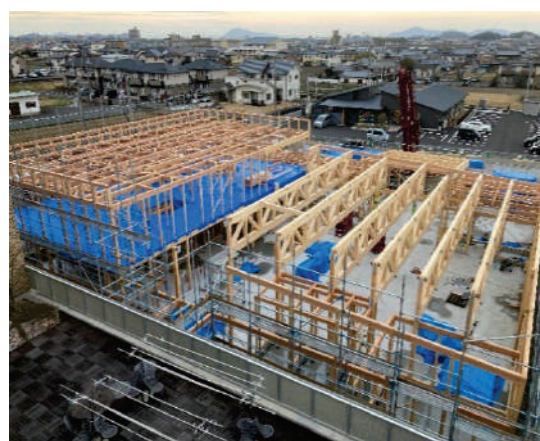
▲トラス吊り込み
