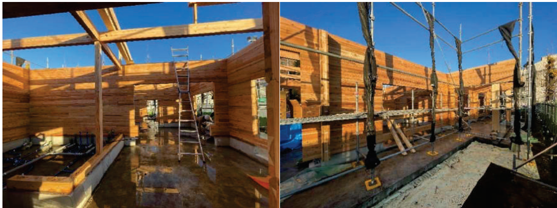
写真 4-6 CLT ログ壁の施工完了
