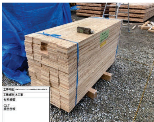
▲CLT 接合合板（構造用合板 t 28）
