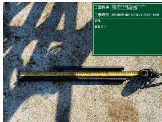
写真 4-5 ダボ施工時の様子
