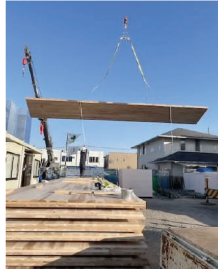
○ 施工順にCLTを重ねている
