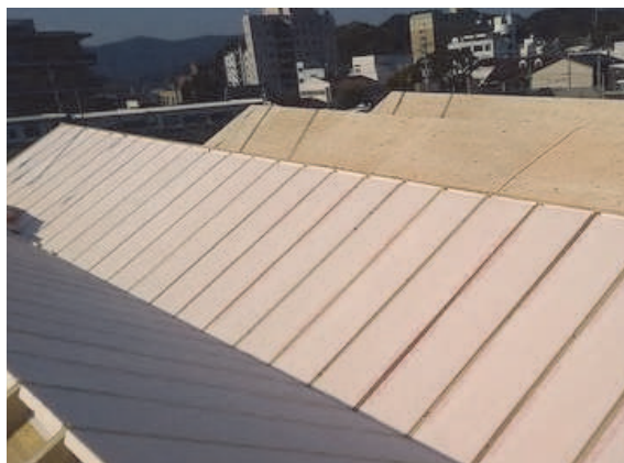
○断熱t90のスタイロフォーム材敷き込みの様子
