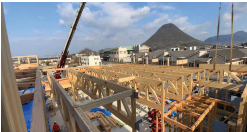
▲トラス吊り込み
