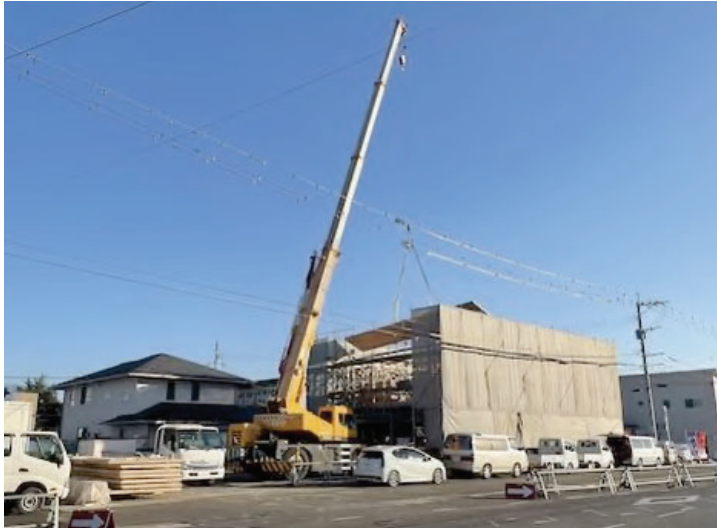
○ CLT折版屋根の建方の様子
