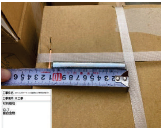
▲接合金物（M16 ドリフトピン）
