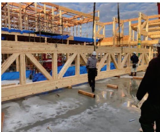
▲現場トラス組立
