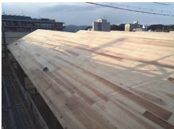
○CLT折版屋根の施工完了時
