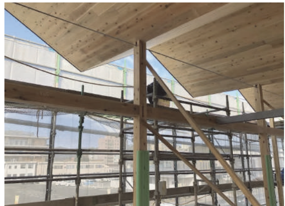
○柱頭金物AとCLT折版屋根の取り付け
