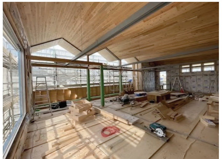
○事務室(2階) H鋼は照明ボックスの上下にLED照明を設置。天井を照らす間接光はまちの街灯の役割を果たす。
