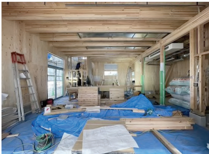
○作業場1、作業場2(1階) CLTの折版屋根の天井を綺麗に見せるため、2階事務室の空調は床吹き出しとしている。1階作業場2の天井に空調機を設置し、2階の床を構成する梁の間にダクティングをしている。
