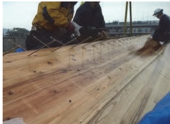
○ CLT同士をパネリードで接合する様子
