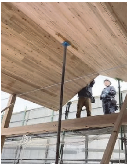
○ X2-X5の壁が無い範囲は、山部にCLT折版屋根の位置の調整を行った
