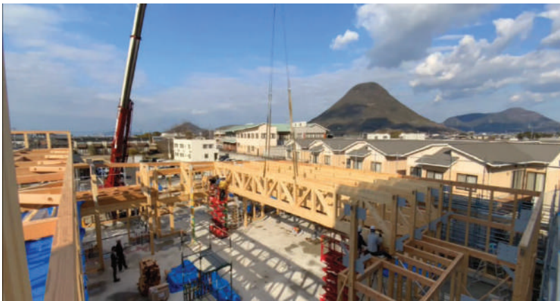
▲トラス吊り込み
