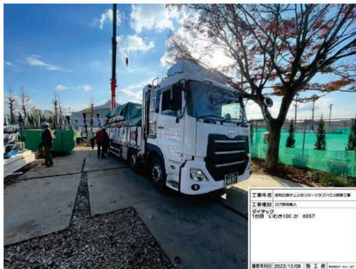
写真 4-1 資材搬入状況
