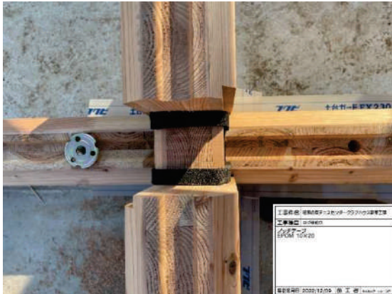
写真 4-3 ノッチ部の精度が高く隙間がない
