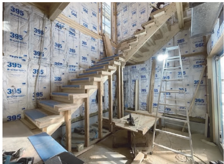
○ 規格寸法がW=2,300の為、屋根として使わない余りの部分を階段の踏板として活用する
