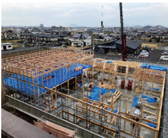
▲トラス吊り込み
