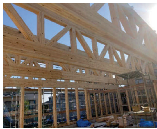
▲トラス吊り込み
