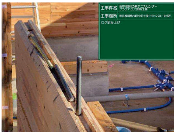
写真 4-5 ダボ施工時の様子
