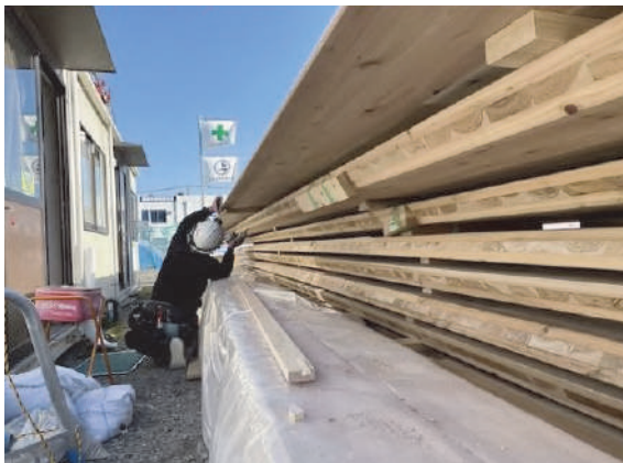
○ パネリード接合部は予め地上で下穴を開けている
