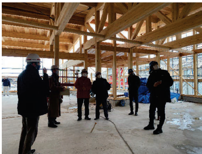
◀建て方完了後の内部の様子
