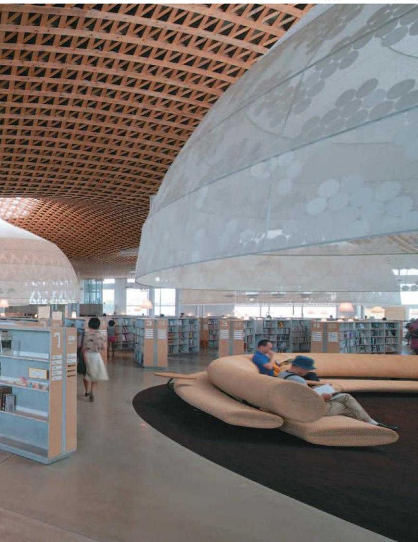
図書館が入る建物の2階全体を木造のシェル屋根が覆う。起伏の付いた屋根は、断面が20×120mmの地元のヒノキ材を、三角形の格子状に組んで積層させたもの。起伏のない平坦部ほど積層数を増やして剛性を高めている。建物内部には、屋根が盛り上がる箇所ごとに、半透明の「グローブ」が天井から吊られており、その頂部は採光や自然換気に用いる開閉式のトップライトになっている。
