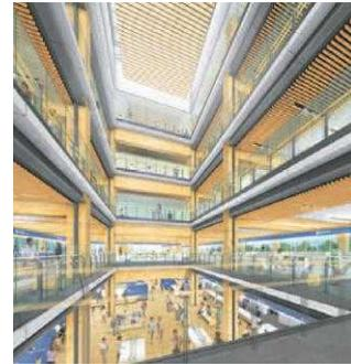
山口県長門市で、2時間耐火の大規模木造による新市庁舎の設計が進んでいる。地上5階建てで、延べ面積は約7100㎡。東西に建つ鉄筋コンクリート造のコアで木造部を挟む「平面混構造」を採用し、免震構造も組み合わせる。ほぼすべての木材を市産材で調達し、1階は2時間、2階以上は1時間の耐火集成材を、現しの柱・梁として使う。木造部には、木質感のあふれる5層吹き抜けの「エコボイド」も設ける。2020年度にグランドオープンの予定。
