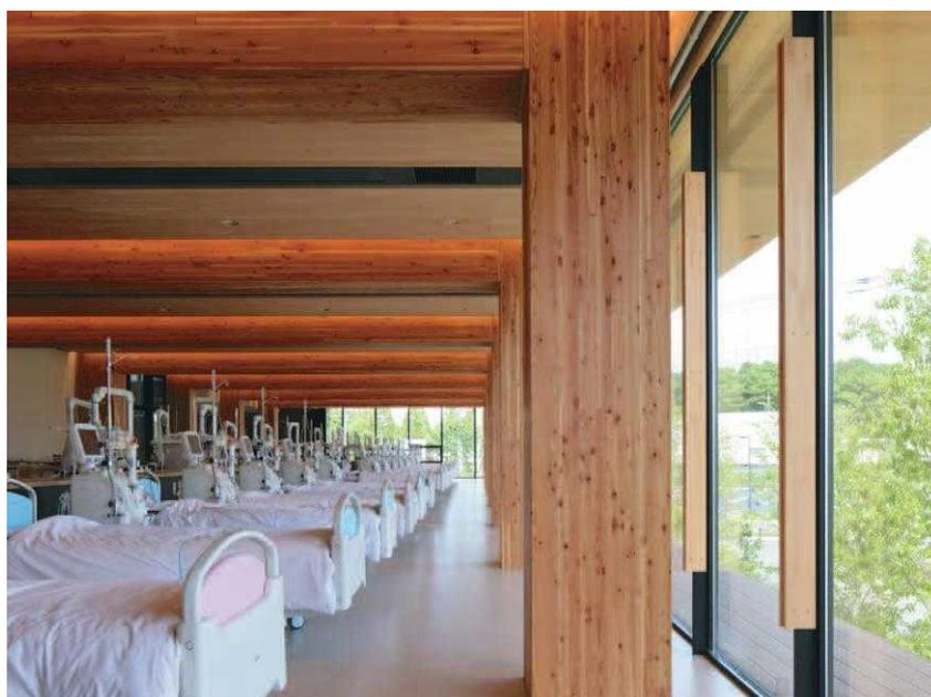
■ 新柏クリニック 所在地：千葉県柏市 主用途：診療所 発注者：医療法人社団中郷会新柏クリニック 設計者・施工者：竹中工務店 延べ面積：3131.93㎡ 構造：鉄筋コンクリート造、木造、鉄骨造 階数：地上3階 主な構造用木材：耐火集成材(カラマツ) 耐火性能：耐火建築物 完成：2016年1月
