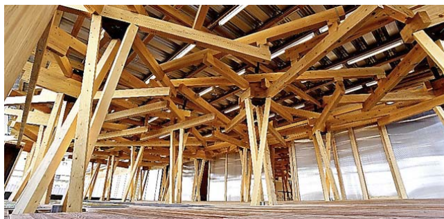
写真 2.1-1 選手村ビレッジプラザ 架構
