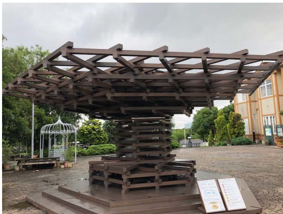
写真 2.1-11 施工後の様子
