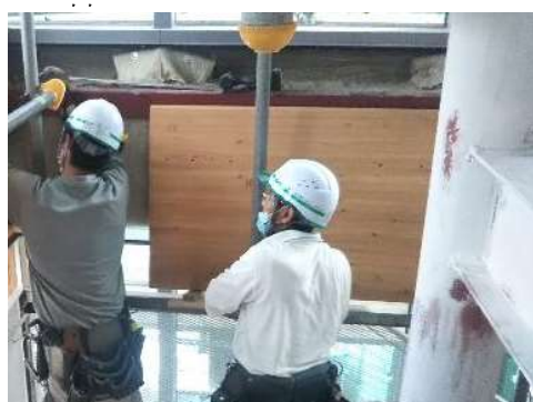
写真 2.2-3 木カバー取り付け
