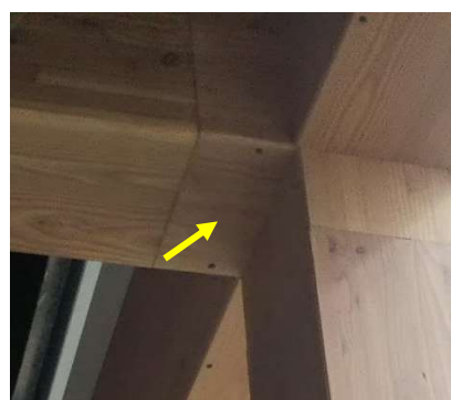
写真 2.2-4 接合部木カバー
