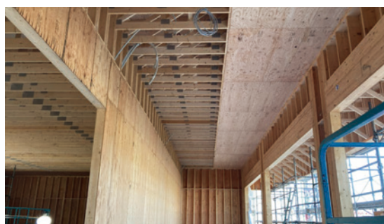
建設工事中の木造店舗（四国中央店 建設当時）
