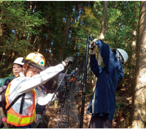
シカ防護柵の設置作業
