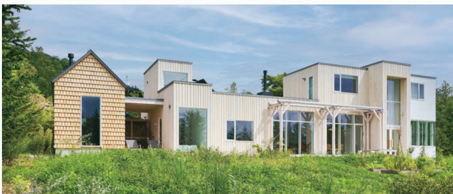
北海道産の木材を利用した木造の宿泊施設「MAISON SHIRO」（2024年4月オープン）
