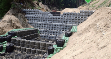
応急対策完了(珠洲市大谷町)
