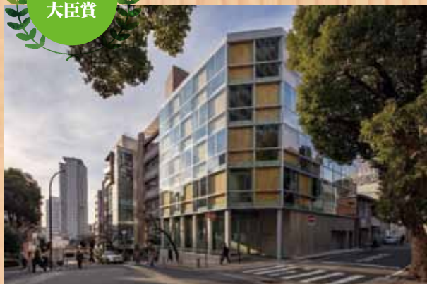
兵庫県林業会館（兵庫県神戸市）：ガラス越しに見られるCLTが柔らかな都市景観を形成（写真提供：株式会社竹中工務店）
